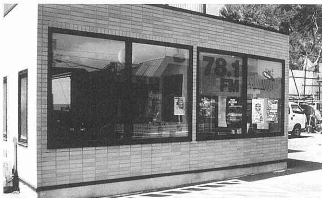
「BAY WAVE」局舎外観
