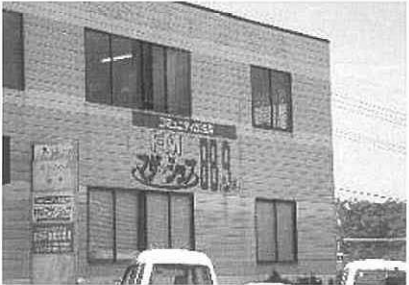
「マザーシップ」局舎外観
