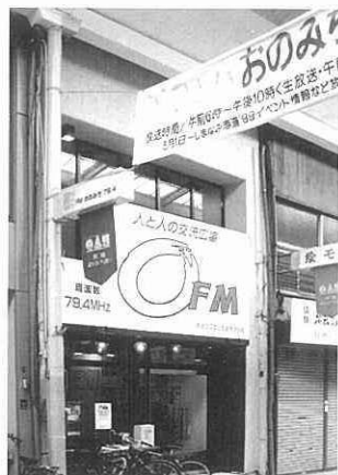
「エフエムおのみち79.4」局舎外観
