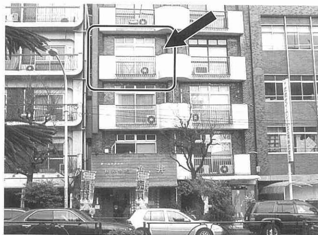
旧事務所の所在したビル(東京都港区六本木) 1992(平4)～2002(平14)年
