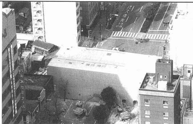
本震で傾いたビルが余震で倒れ、6車線の大通りを完全にふさいでしまった =1995(平7)年1月18日午後、神戸市中央区 (提供/「産経新聞緊急増刊・神戸大震災」)
